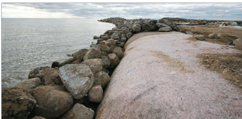
Tubo SoilTain CP como núcleo de espigón, revestido con geotextil no-tejido y enrocado
