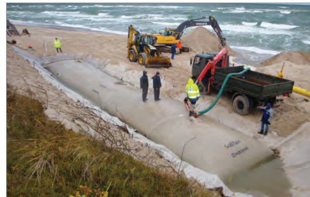
Tubo SoilTain CP como barrera para formación de duna artificial
